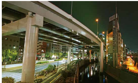
高速5号池袋線飯田橋駅付近
