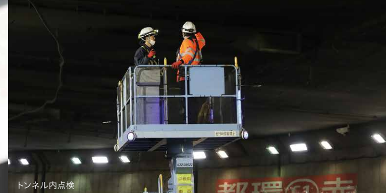
トンネル内点検
