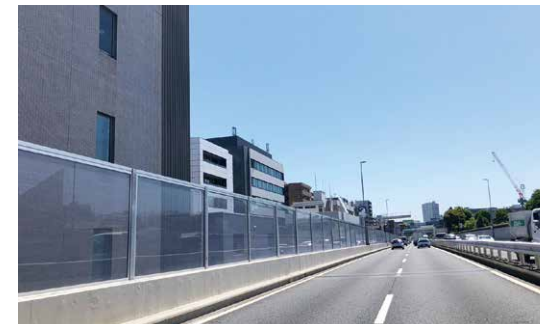
高速5号池袋線護国寺付近
