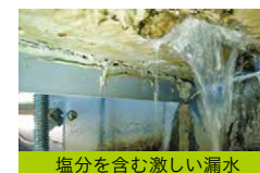
塩分を含む激しい漏水
